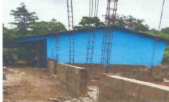
FOTO 2: PARTE DE ENFRETE DEL AULA DE 1ERO BASICO PARA CONTINUAR CON LEVANTAMIENTO DE PAREDES
