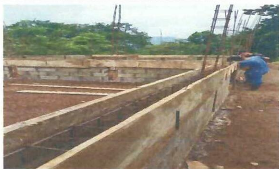
FOTO 1: SE OBSERVA QUE YA SE TIENE BASES PARA CONTINUAR CON EL PROCESO DE PAREDES
